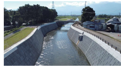
工事名 鎌田川6工区河川工事（一部債務）（余フ）
