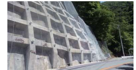
工事名 国道358号 災害防除工事（2工区）（明許）（余フ）
