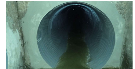
工事名 下水道改良工事（長寿命化H28-3）
