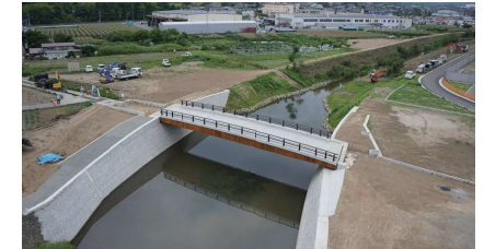
工事名 道路改良工事（市道下曾根2200号線）橋梁工事
